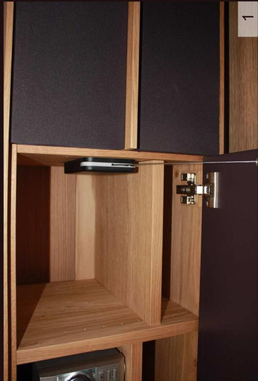
**1** Im hinteren Bereich ist die geteilte Rückwand ersichtlich, welche einen Kanal für Kabel bildet
